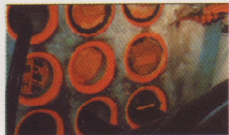
地下人孔內主牆管口防水及預留管口堵塞處理
