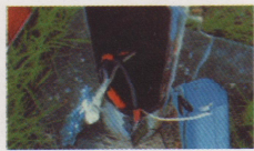
公園路燈柱管口防水處理
