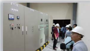
發電機併聯盤（緬甸）
