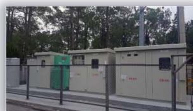
太陽能發電系統併聯盤
