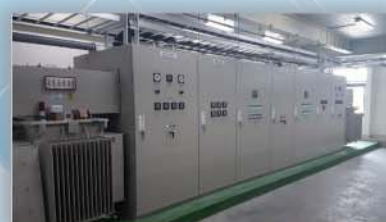
69KV變電站控制盤
