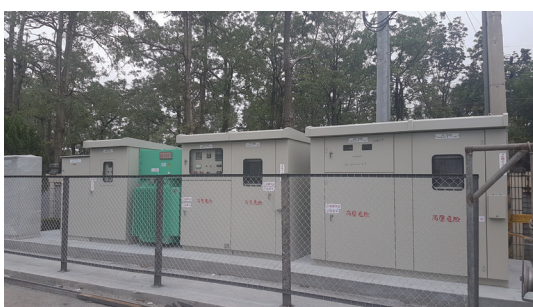
69KV/22.8KV/11.4KV 高壓併聯盤
